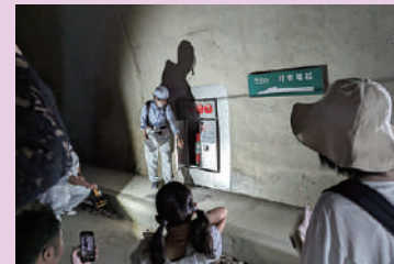
インフラツーリズムで行った工事中のトンネル
